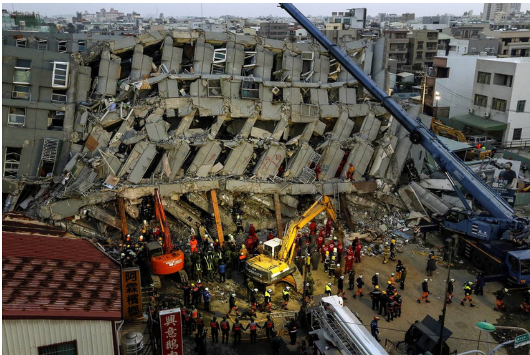
Edificio crollato durante il terremoto del 06.02.2016 a Taiwan, Mw 6.4 Fonte: https://www.wsj.com/articles/taiwan-officials-launch-rescues-1454816862
